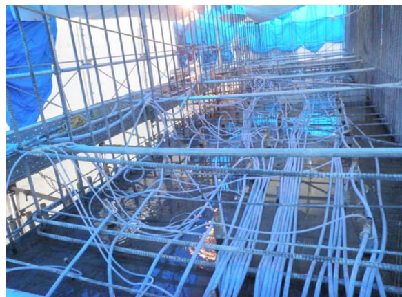
写真－1 パイプクーリング設置状況
