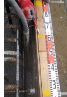
写真3 締固め用のマーキング状況
