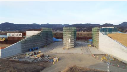
写真1 大林水門の施工状況全景
