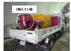
写真-2 ミスト養生設備
