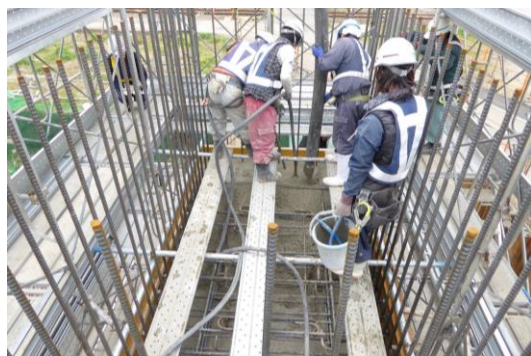
写真1 試行および打込み状況
