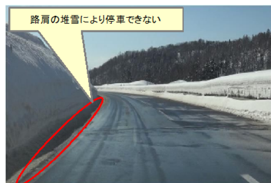
＜図-5 堆雪により路肩停車できない状況＞
