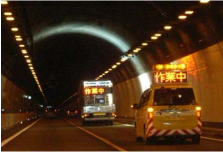
写真-1 覆工表面画像撮影状況
