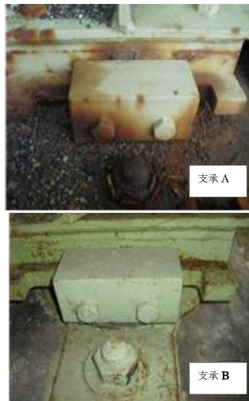
図 2 各支承の外観状況
