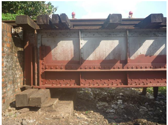
図-1 Phase1 で作成した補修図面と Phase2 にて MR が実施した補修状況
