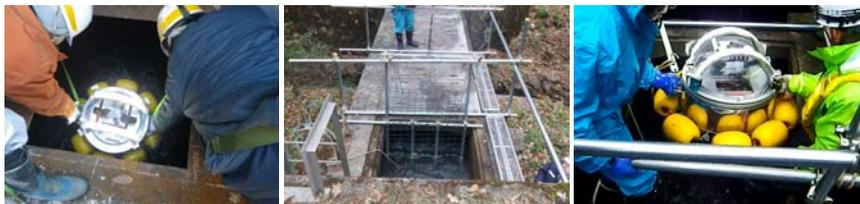
写真2 点検の状況(左:調査機投入 中:回収口 右:調査機回収)
