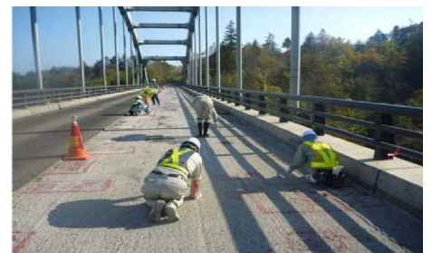
写真-1 打音試験状況
