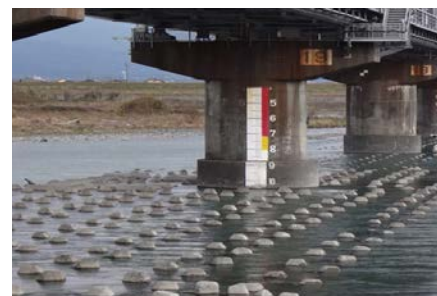
図2 桁下水位標と根固め工
