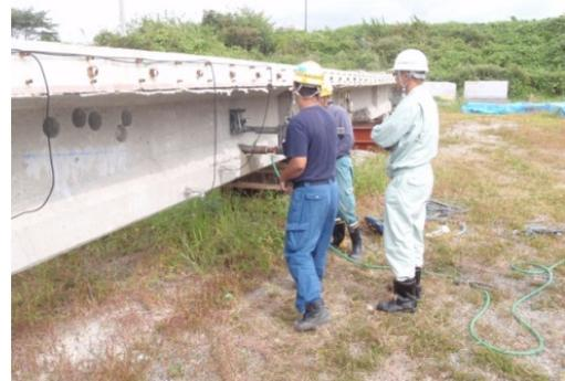
写真 2.1 PC 鋼材のコアカッタによる切断状況
