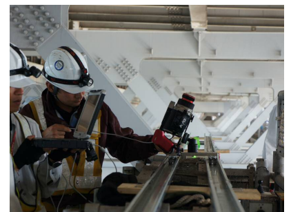
写真1 撮影・録画状況
