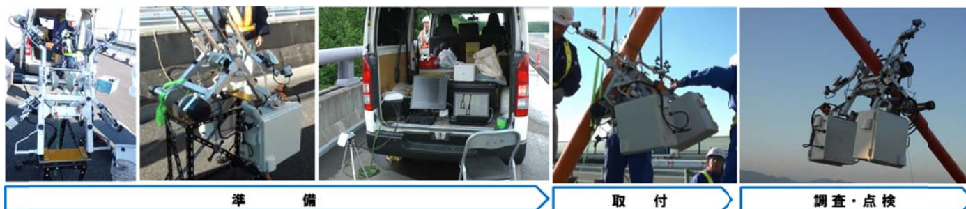
図3 自走式点検装置を用いた点検手順
