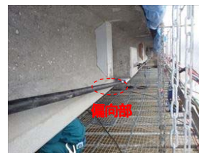
写真-7 ケーブルの偏向部
