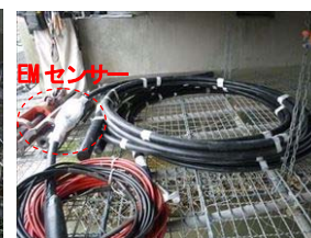
写真-6 搬入時ケーブル
