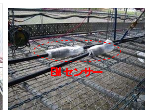
写真-8 EMセンサー（ケーブル設置前）
