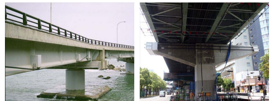
写真-2 外ケーブル補強工法実施橋梁
