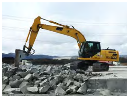
写真-1 一次破碎状況
