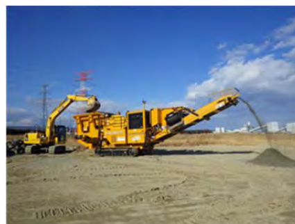
写真-2 二次破碎状況
