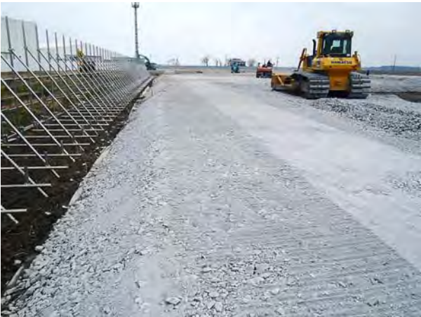
写真－4 破碎材施工状況
