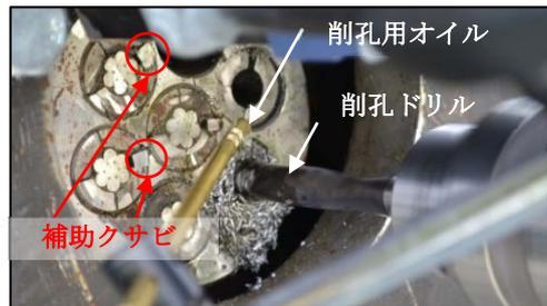
写真-3 ドリル削孔状況 (拡大)
