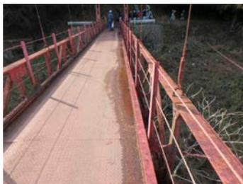
(e) 路面の縞鋼板
