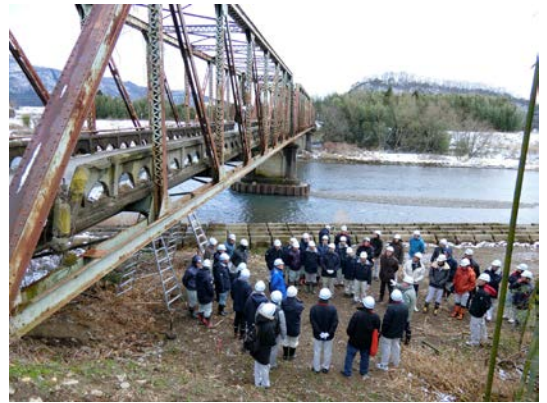
写真-1 橋梁診断
