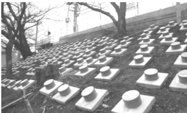
写真－1 盛土修繕工事完成状況
