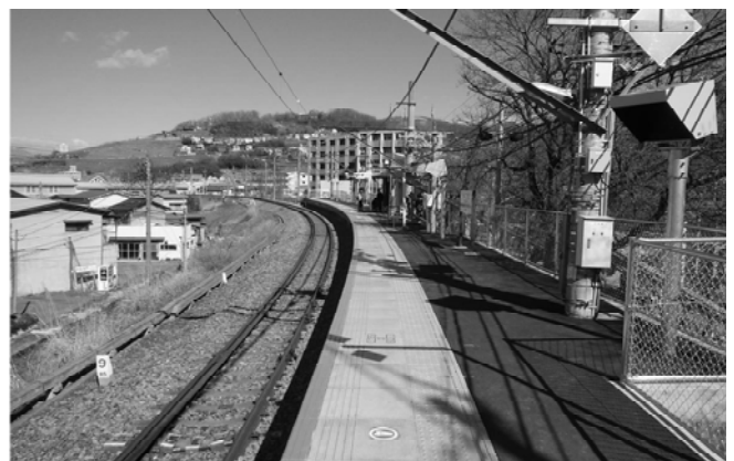
写真－2 ホーム修繕工事完成
