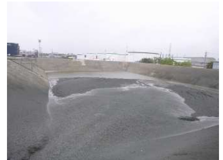
写真-2 浚渫土受入れ築堤内打設状況
