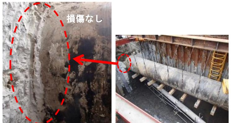
写真-2 掘削直後の既設送水管状況
