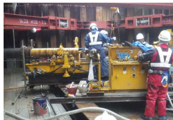
写真-2 施工状況
