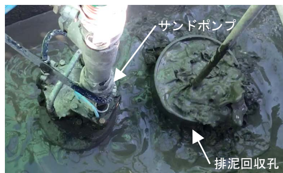
写真-1 排泥回収孔
