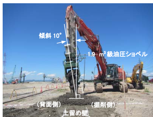
写真-1 施工状況
