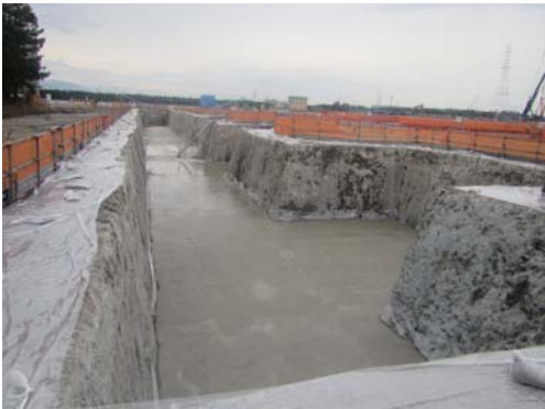
写真-3 掘削完了状況
