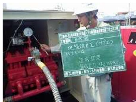
図-4 造成圧力確認
