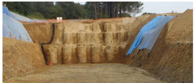
写真-2 開削部境の改良体の壁
