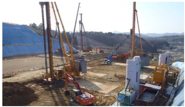
写真-1 RAS コラム工法の施工状況
