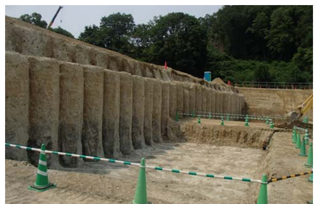
写真-3 地盤改良部および土留め部の出来形
