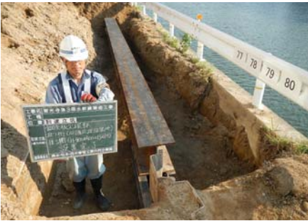
写真-2. 渡り桁設置状況
