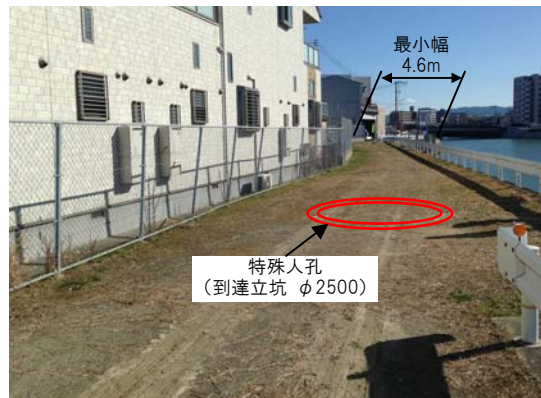
写真-1 着工前の現地の状況
