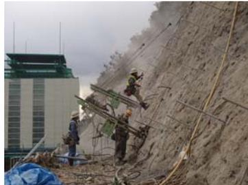
写真-5 鉄筋挿入工(無足場工法)
