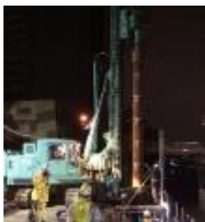
写真-1 鋼管杭施工状況
