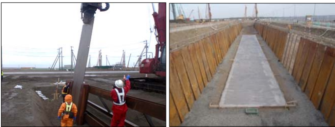
写真-2 横矢板打設
