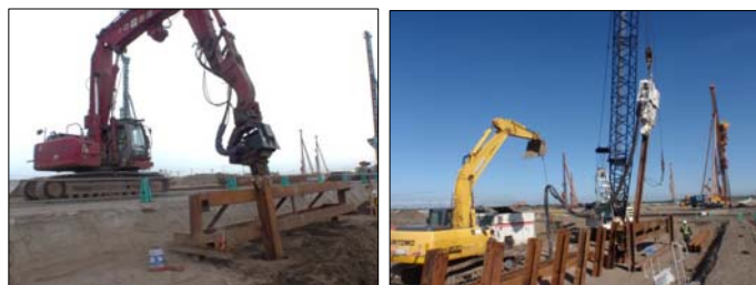
写真-1 親杭打設(左:A工法、右:B工法)
