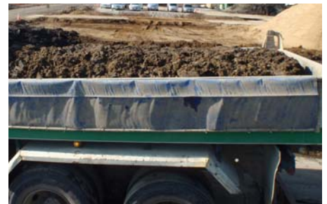
写真-2 掘削土の運搬状況例
