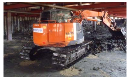
写真-3 掘削作業状況
