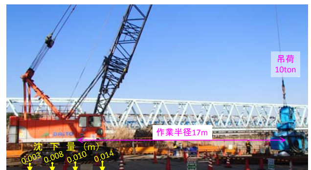
図-5 揚重作業状況
