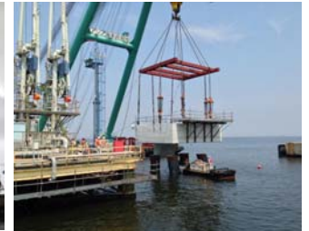
写真-2 杭打込み状況 写真-3 ハーフプレキャストの設置状況
