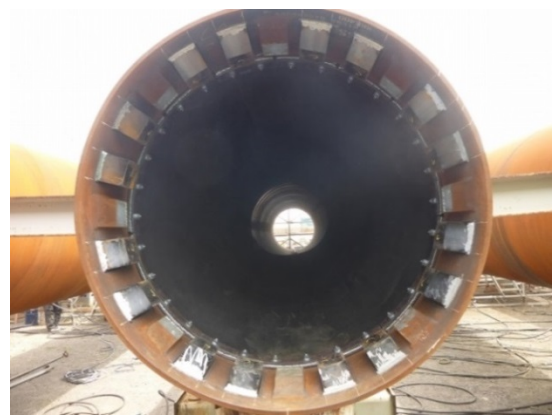
写真-2 シール材取付状況
