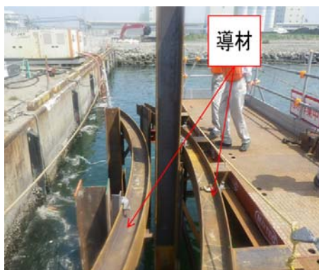
図 3 アーク矢板打設に用いる導材
