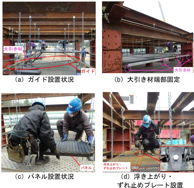
図-7 パネルを用いた施工状況
