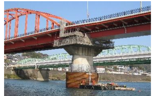
写真-1 仮締切工法施工状況
