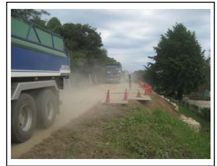
写真-3 搬入用道路の退避場
