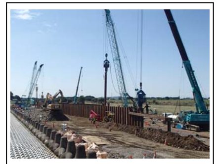
写真-5 二重締切鋼矢板の打込み状況
