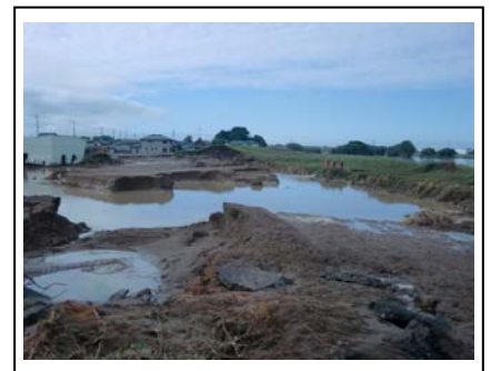
写真-1 鬼怒川堤防の決壊状況
