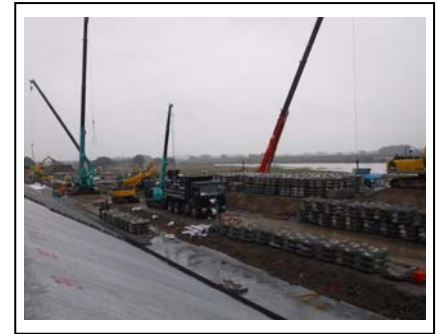
写真-4 連節ブロックの仮置状況
