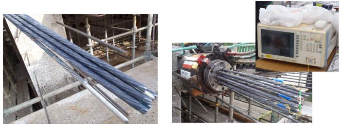
① 光ファイバ組込み式 ECFストランド ② 緊張・計測
