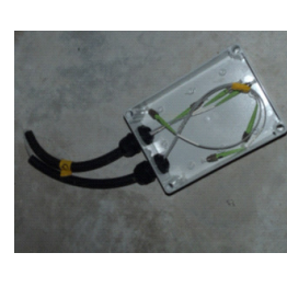
④ 桁内への配線
