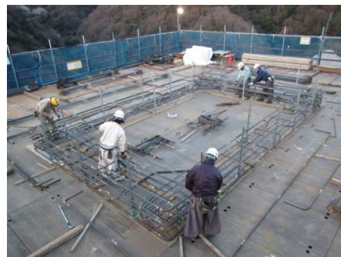
写真-2 試験施工状況
