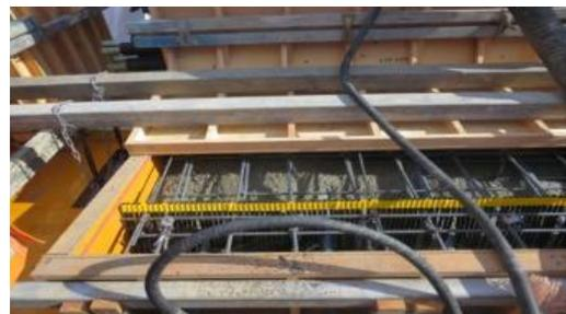
図-8 櫛型枠の設置状況
