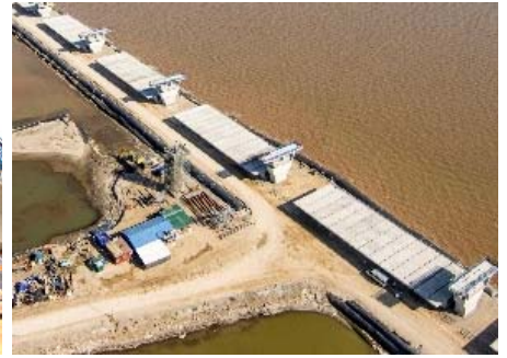
写真-6 先行仮置きされたセグメント
