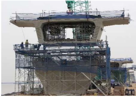
写真-3 ハーフプレキャストセグメント架設
