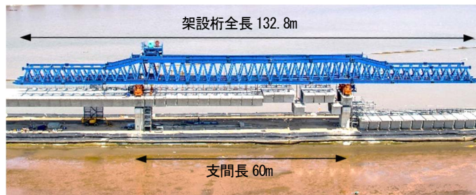
写真-1 架設桁によるセグメント架設状況
