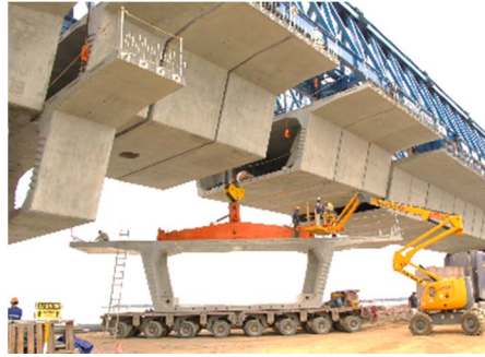
写真-5 セグメント運搬・吊上げ
