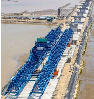
写真-4 上空からの架設状況全景
