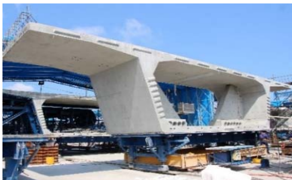
写真-2 ショートラインマッチキャスト方式の型枠設備
