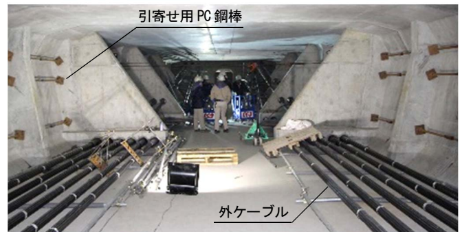
写真-7 桁内 PC 鋼材配置状況
