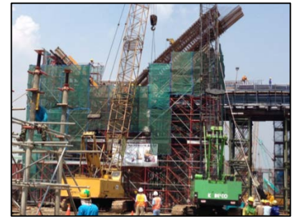
写真 1 鉄筋籠吊込状況
