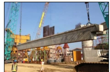
写真 3 クレーン架設状況
