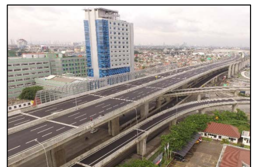
写真 4 現況写真(本線とランプ)
