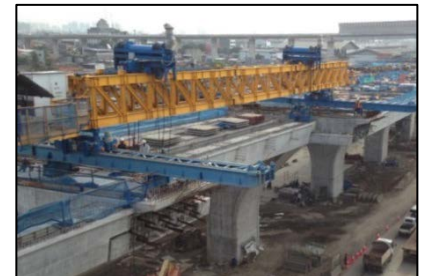
写真 2 架設桁架設状況
