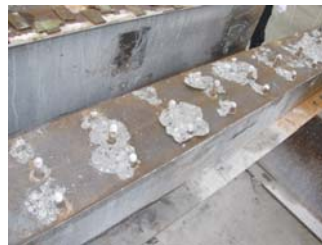
写真-5 床版撤去後の桁上（コア削孔試験体）
