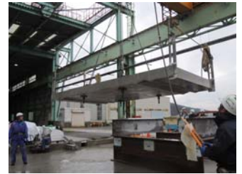
写真-4 床版吊上げ状況
