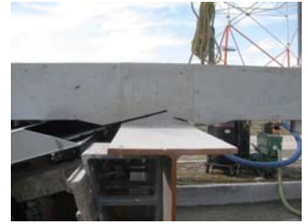
写真-2 ウォールソー切断完了（断面）
