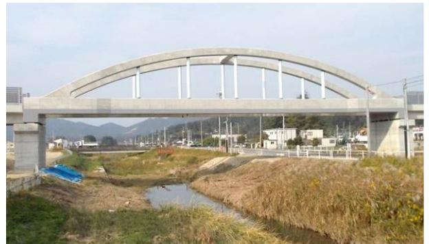
写真-1 PCランガー橋の全景
