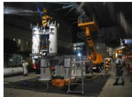
写真-4 低空頭での柱架設状況
