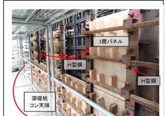
写真-1 CF工法の施工状況
