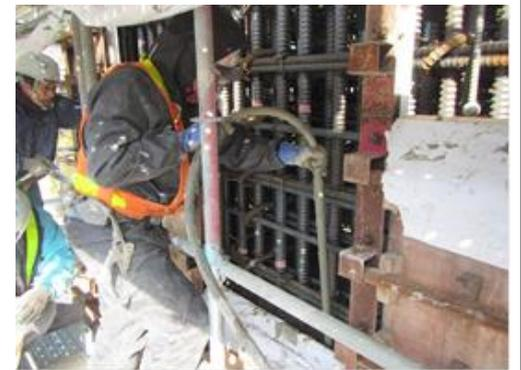
写真-2 CF工法の打設状況
