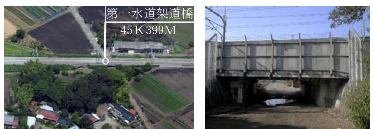
図-3 表面保護工施工箇所
