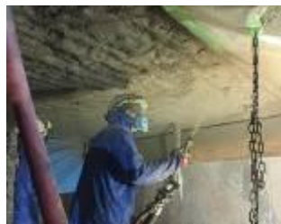
写真-13 吹付け状況
