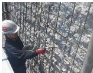
写真-6 防錆材塗布
