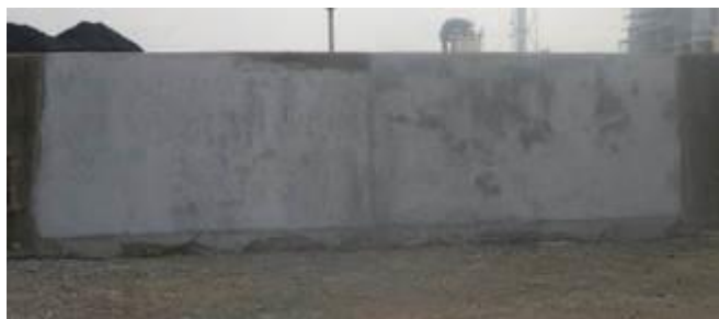
写真-10 試験施工完了全景
