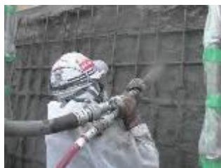
写真-8 吹付け状況
