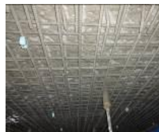
写真-12 防錆材塗布
