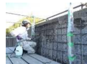
写真-7 プライマー塗布
